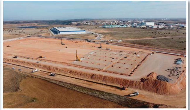
Avance de las obras en el PTL
